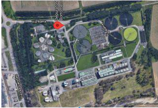
PESCHIERA BORROMEO WWTP
